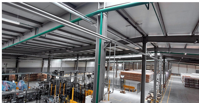
STEEL FRAME · NAMANGAN
